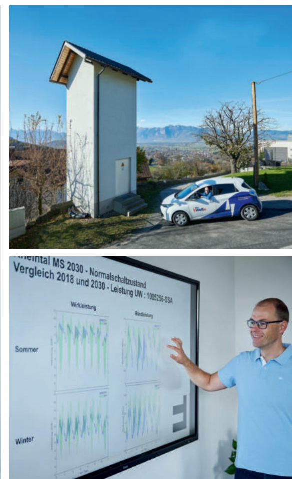
Anhand der Simulation werden die Auswirkungen auf das Stromverteilernetz deutlich.
