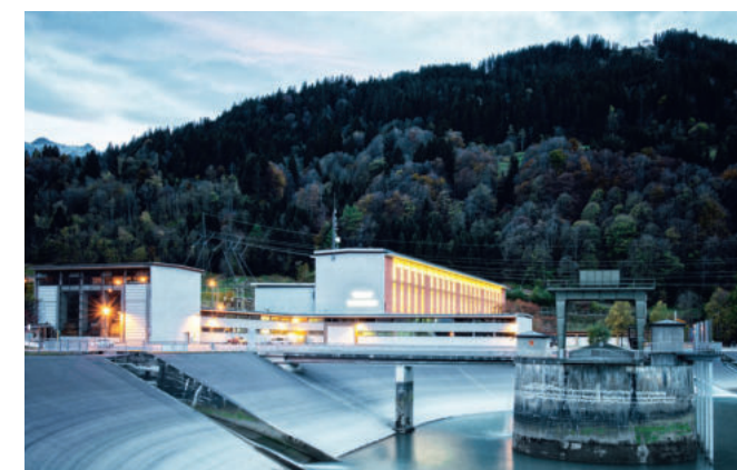
Kraftwerk Andelsbuch (oben) und Lünarseewerk I (unten)
