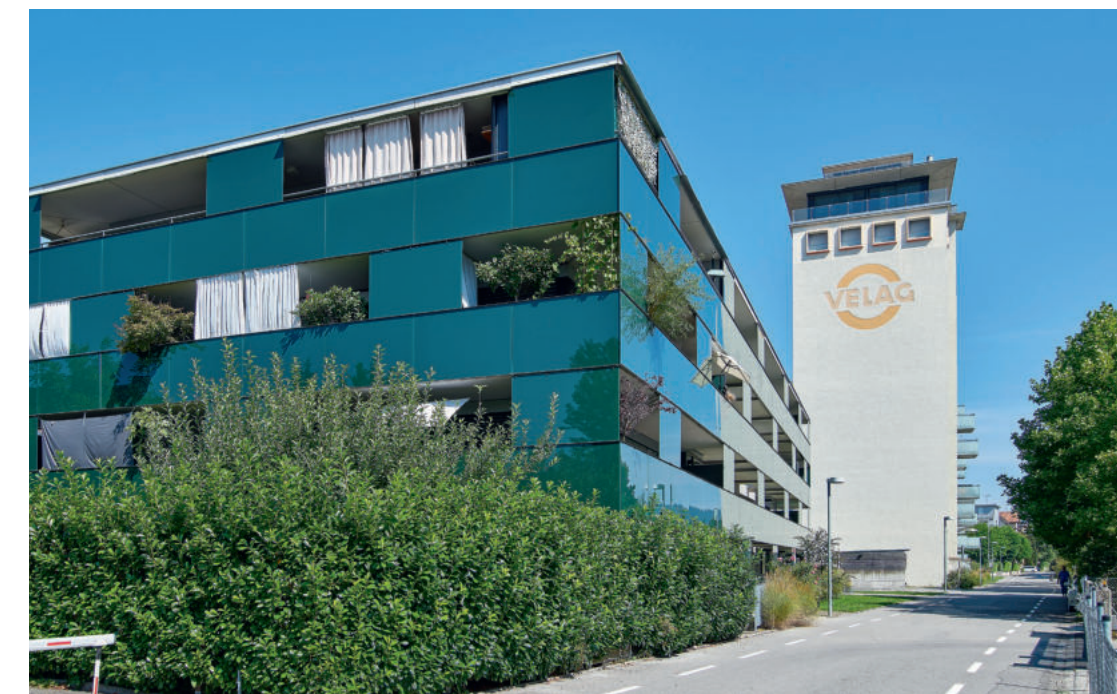
Sieben Ladestationen sind in der Wohnanlage in Bregenz inzwischen verbaut und in Betrieb.
